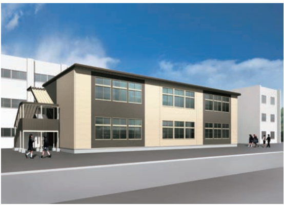
新校舎：地上2階建て 鉄骨作り 奥行き約10m 幅25m 高さ7.9m 6教室
